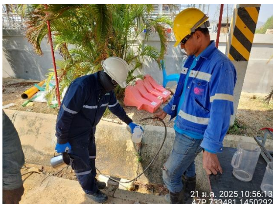
รูปที่ 3-10 การติดตามตรวจสอบคุณภาพน้ำทั้งจากการทดสอบการรั่วไหลของท่อด้วยวิธีชลสถิต (Hydrostatic Test) ของโครงการฯ ในระยะก่อสร้าง
